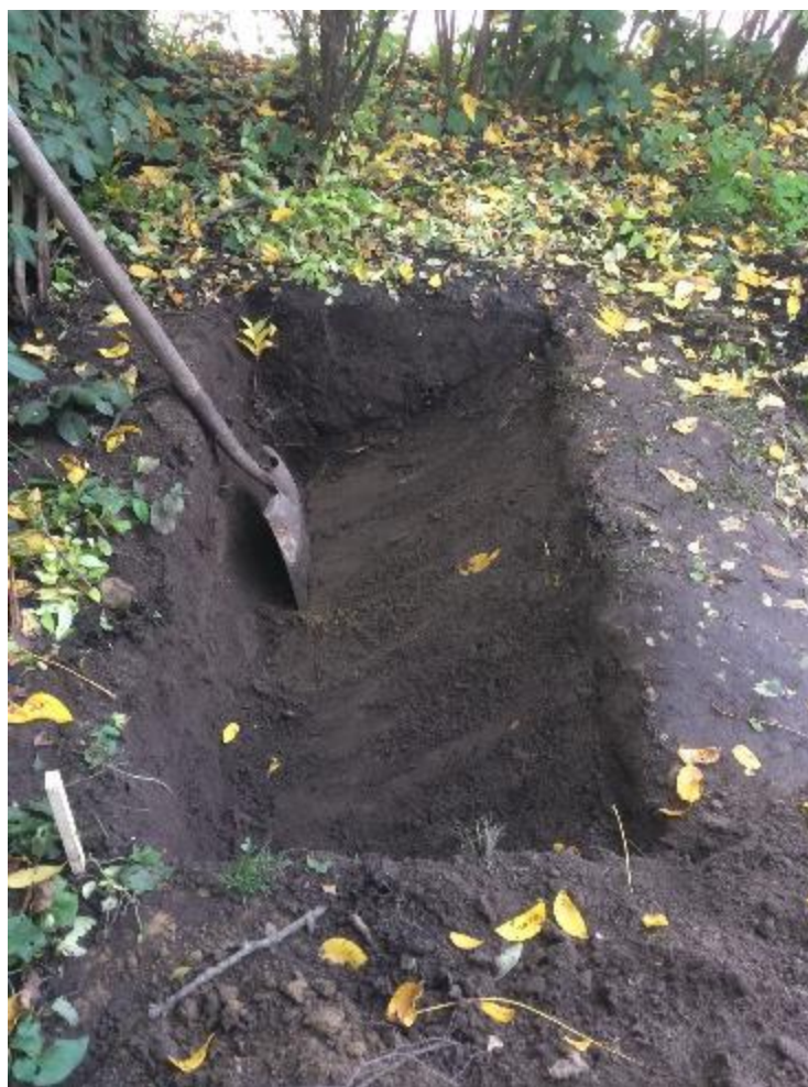
Digging the pit.
